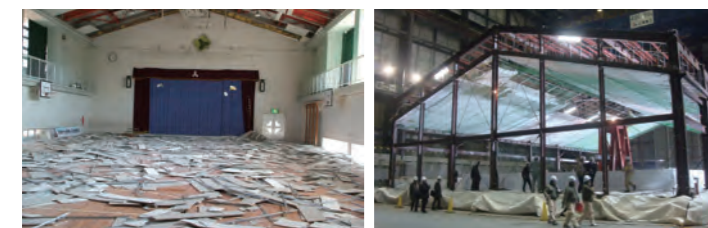
能登半島地震における天井の被害 実大体育館による天井の振動台実験
