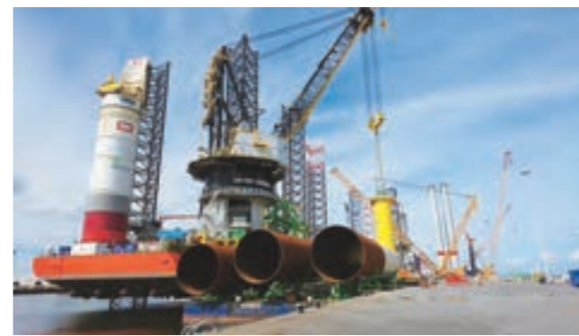
作業船(SEP船)に風車の支柱を積み込む様子
