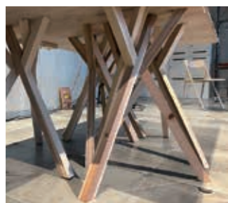
高座台 Y字型の木組みを少しずつ回転させて制作した。話し手のアクティブな動きに耐えられるよう、脚元にワイヤーを設置。荷重がかかることでより安定する設計を施した。
